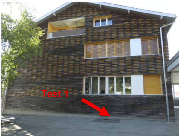
Façade Est du collège
