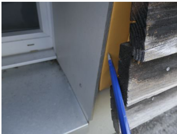
Façade Est de la salle de gymnastique – Test 2
