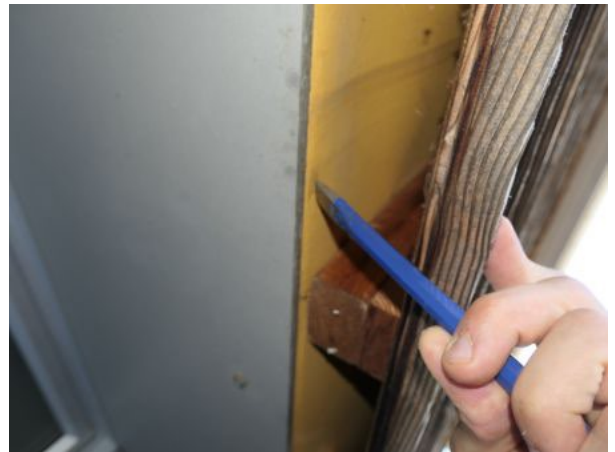
Façade Est de la salle de gymnastique – Test 1
