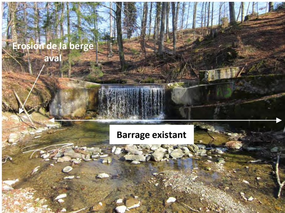
**Figure 6 :** Vue de l'aval du barrage
