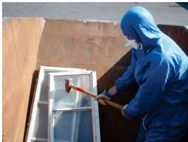
1 Séparation du vitrage au marteau.
